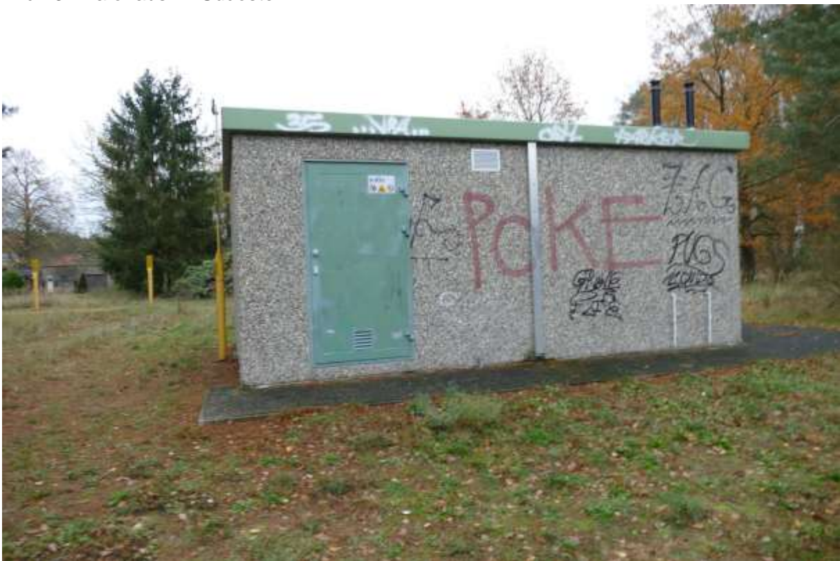
Bild 13: Trafohaus im Südosten
