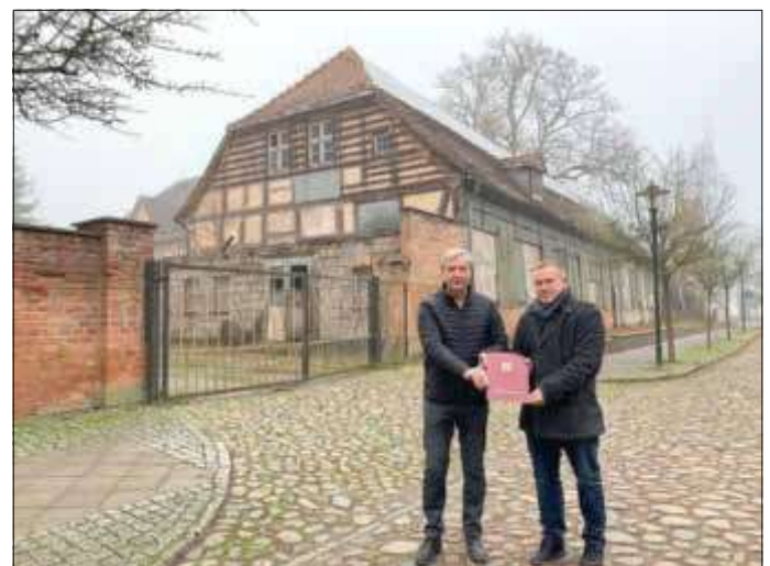
Bürgermeister Henry Tesch und Kämmerer Andreas Franz mit dem Fördermittelbescheid aus Schwerin vor dem Flügelgebäude des Unteren Schlosses in Mirow.
