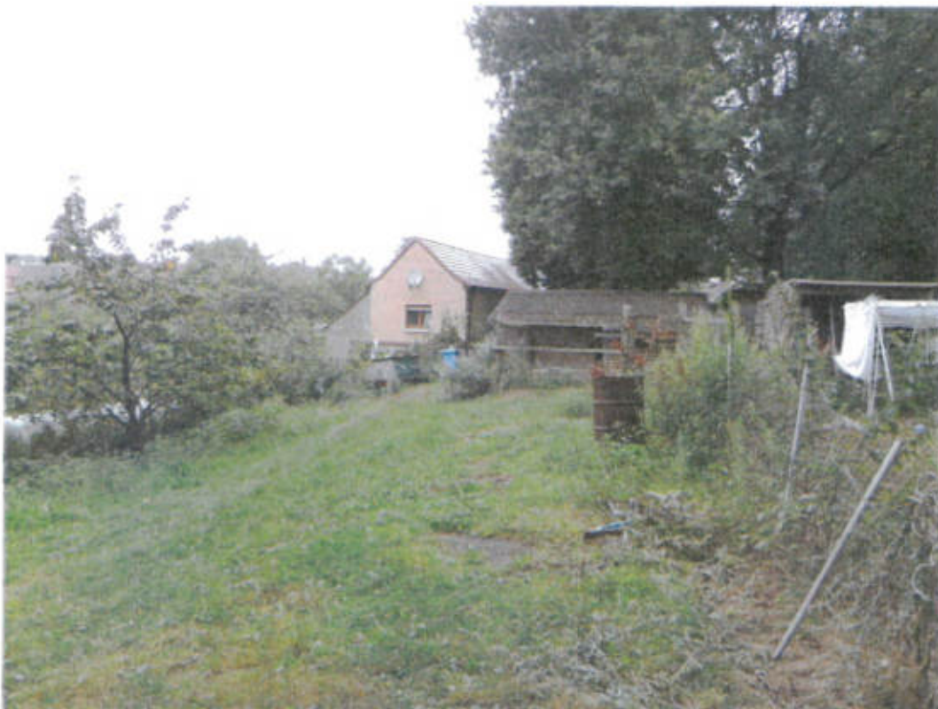
Bild 2 – Gebäude im Park vom Süden
